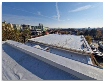
Oprava strechy, Bratislava – Rača
