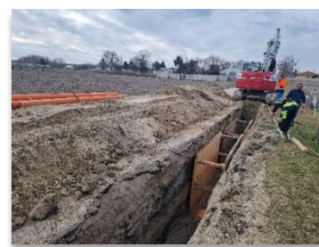
Realizácia kanalizácie, Horný Bar
