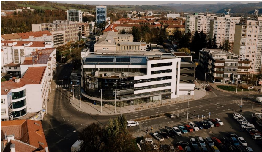
Parkovací dom CENTRUM, Banská Bystrica
