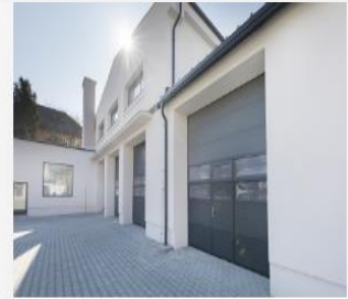
Rekonštrukcia priestorov autoservisu v Rimavskej Sobote
