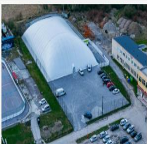
Výstavba tenisovej haly v Čadci
