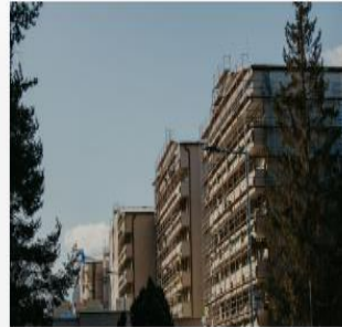
Rekonštrukcia Akadémie ozbrojených síl v Liptovskom Mikuláši
