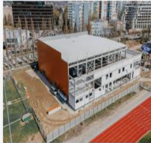
Výstavba športového centra Žilina
