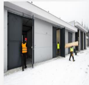
Rozvádzač BTP Horný Hričov
