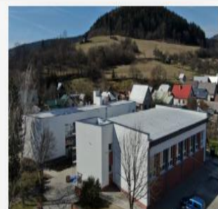
Rekonštrukcia obecného úradu v obci Jasenica
