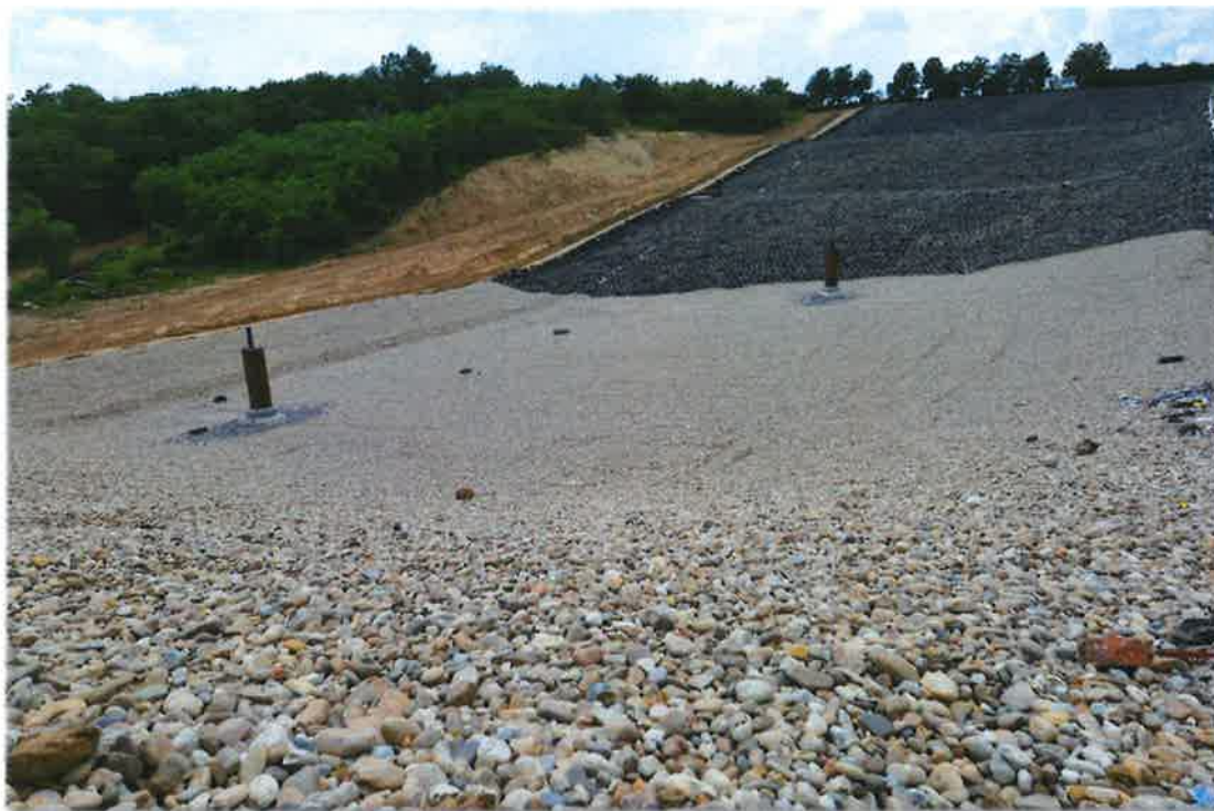
Práce na skládkach Zlaté Moravce – časť A a časť B
