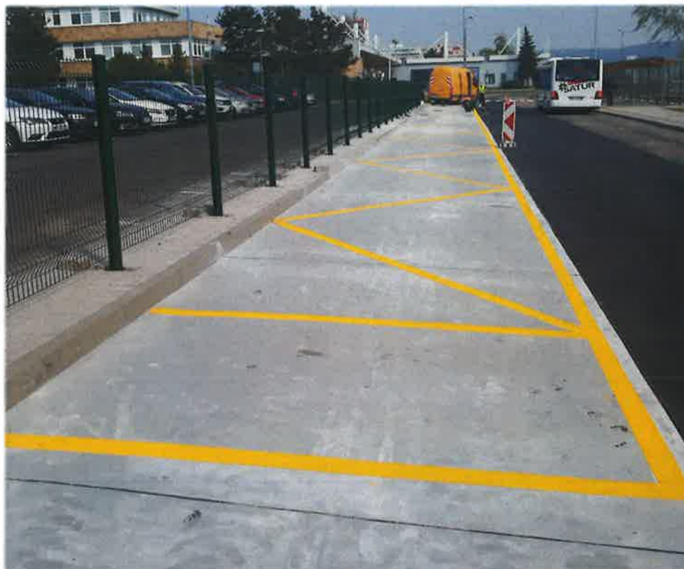
Devínska Nová Ves – kompletne zhotovenie spevnených plôch
