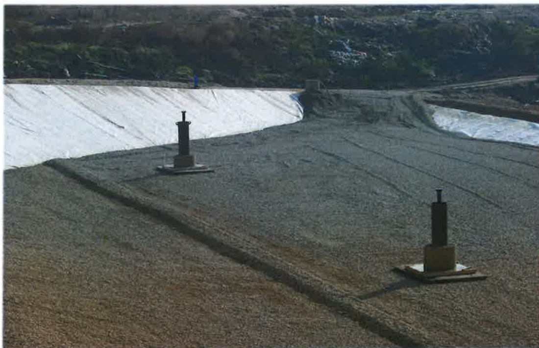
BOJNÁ – skládka odpadov, časť C – 2. Etapa
