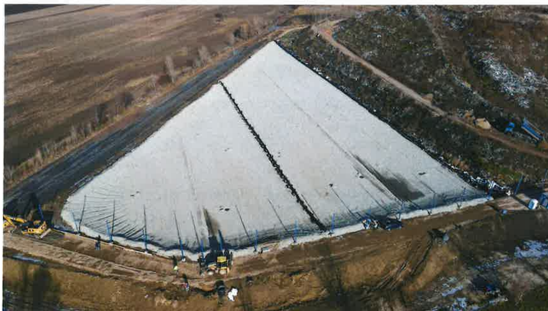
Dolný Bar rozšírenie skládky, III. etapa výstavby, kazety 4-5
