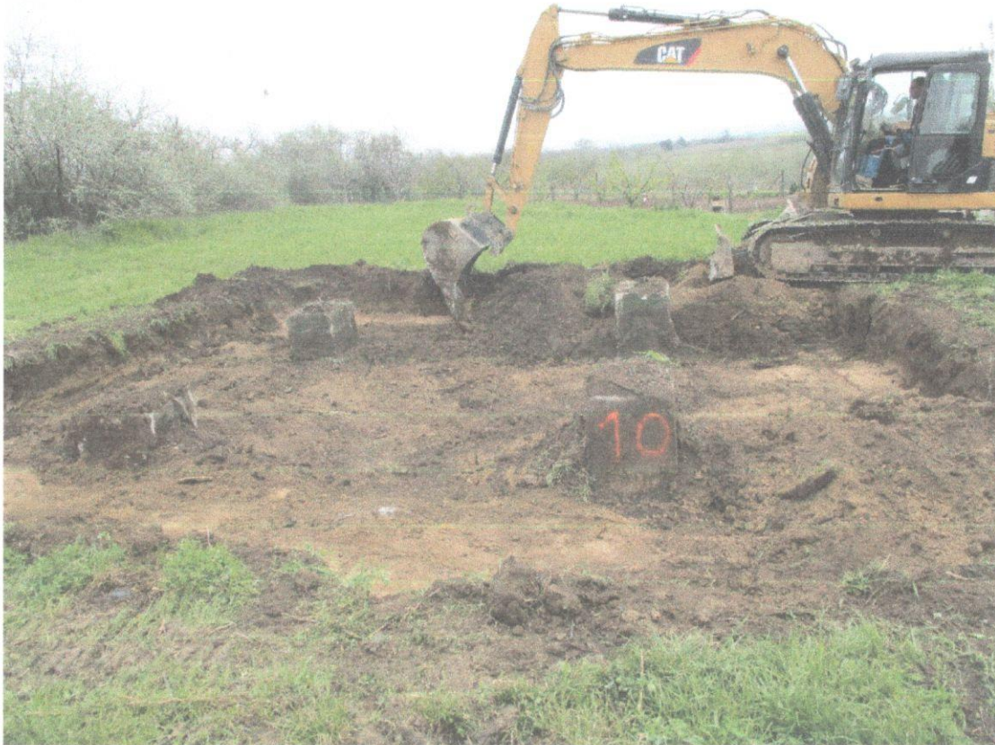
1. Demontáž vedenia V 247 Križovany - Bystričany r. 2023
