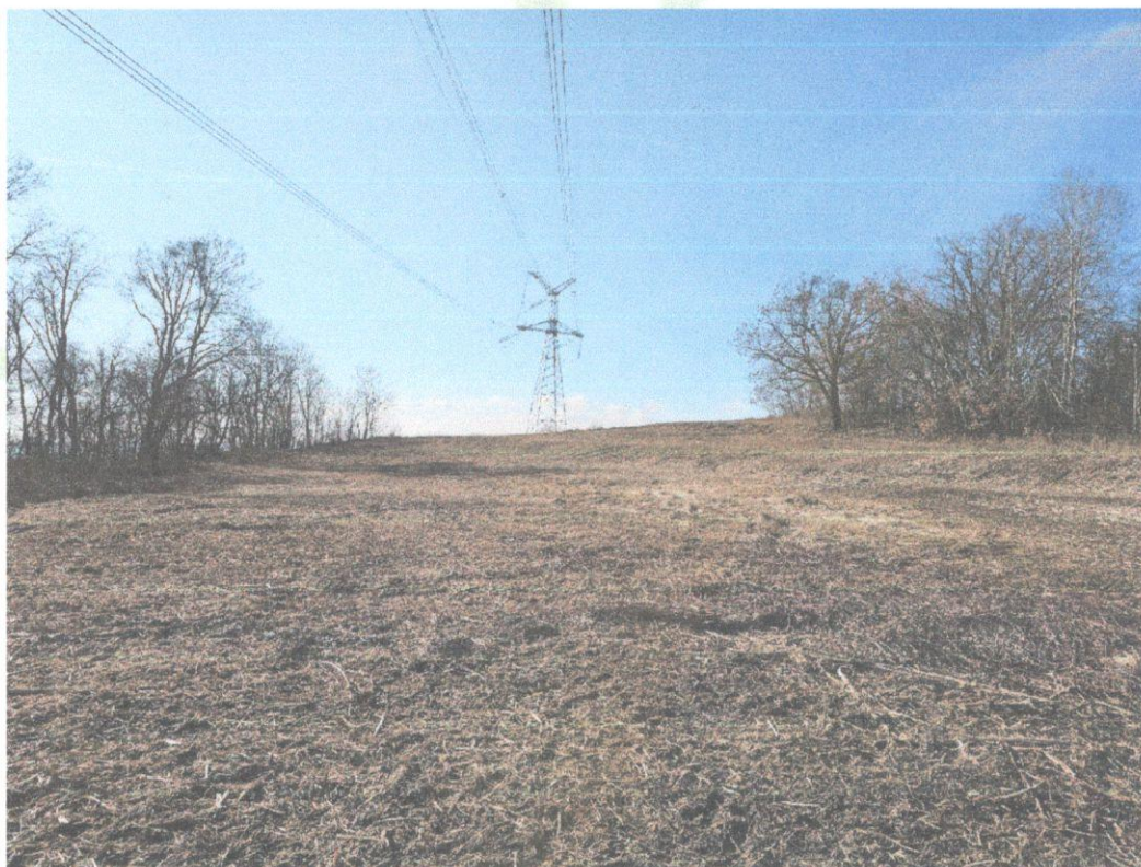
4. Výrub drevín pod vedením V 495 Bošáca r. 2023
