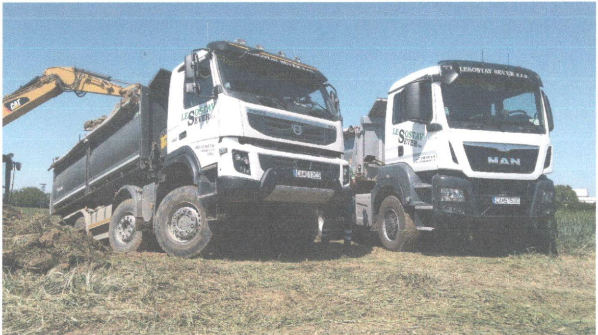
9. Rekonštrukcia vedenia 1 x 110kV V 8761 Trnava
