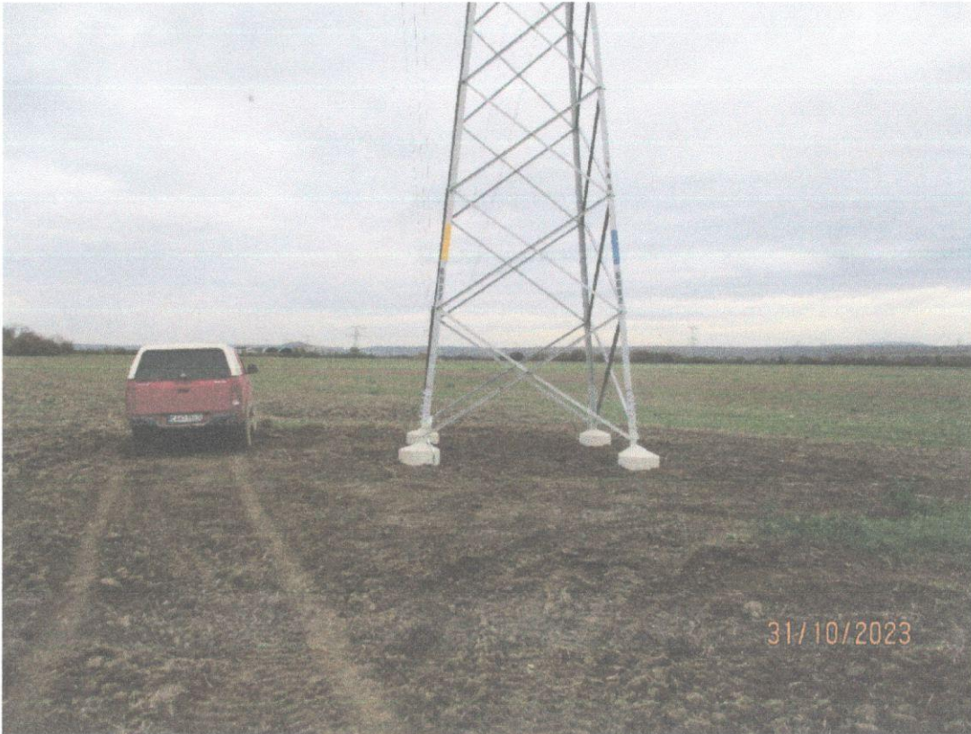
7. Oprava betónových základov stožiarov vedenia 2 x 110 kV Vôľa – Ložín
