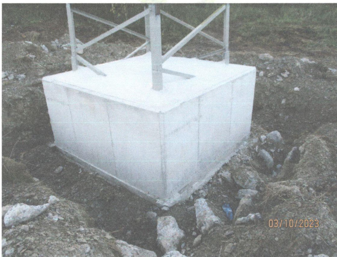
6. Oprava betónových základov stožiarov Raječek – Břidličná r. 2023
