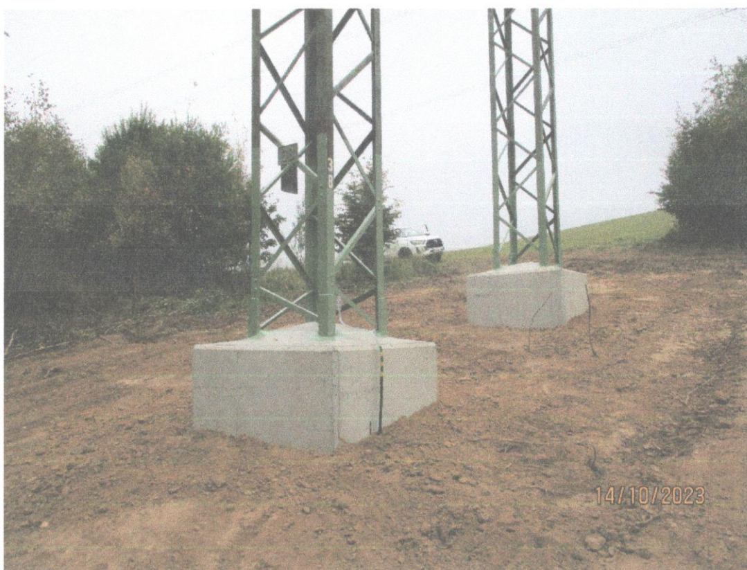
5. Oprava betónových základov stožiarov Raječek – Břidličná r. 2023
