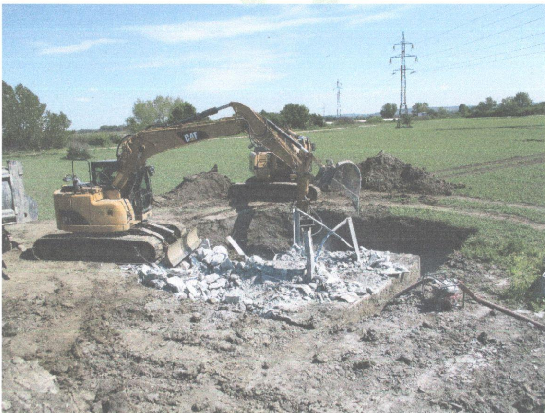
2. Demontáž vedenia V 247 Križovany - Bystričany r. 2023
