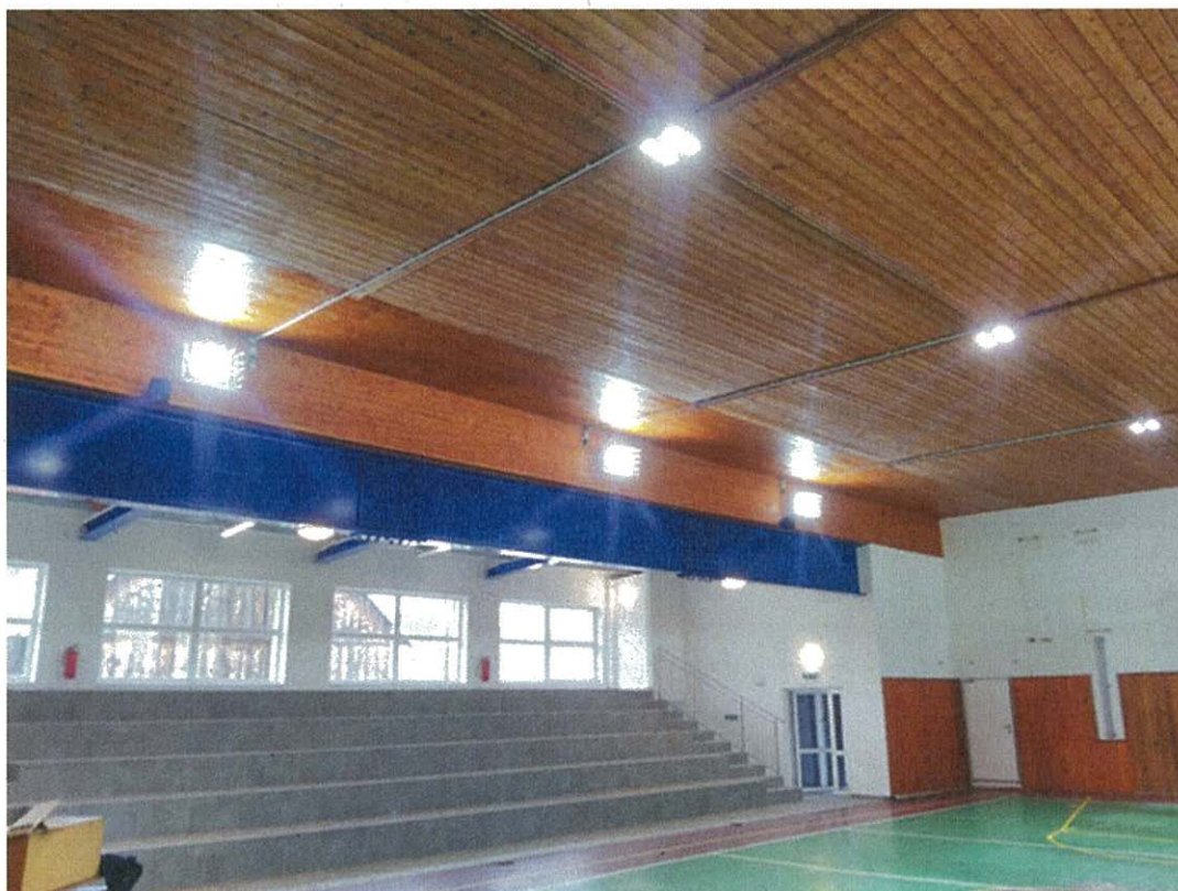
Foto č. 1 - Rekonštrukcia telocvične ZŠ v obci Kamienka
