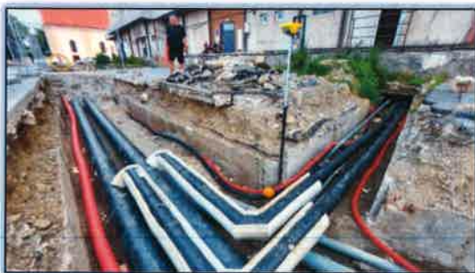
2022/2023 Bardejov rekonštrukcia rozvodov tepla
