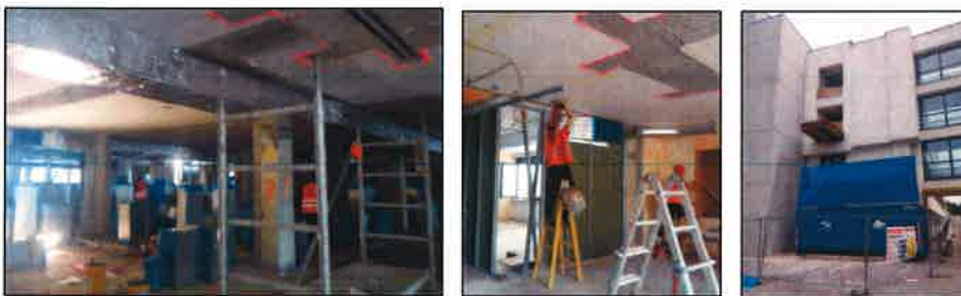
Rekonštrukcia lôžkového pavilónu a HOTFLOOR – Nemocnica AGEL Levice a.s.
