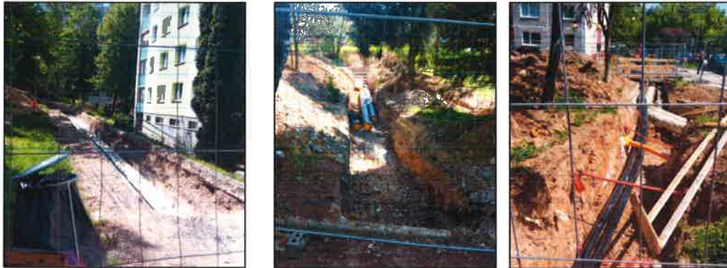
Rekonštrukcie a modernizácie rozvodov CZT okruh OST EGI,2 Rozkvet, Považská Bystrica
