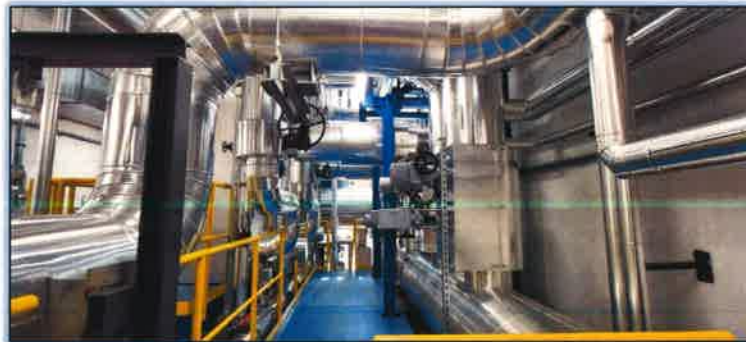
2023 KOSIT Košice kotol K1 rekonštrukcia
