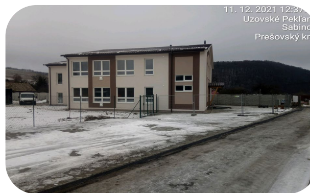
Novostavba ZŠ v Uzovských Pekľanoch
