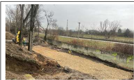
Mestský multifunkčný športový areál Nové Zámky - Sihot' – chodníky; 2022
