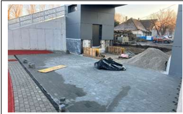
Mestský multifunkčný športový areál Nové Zámky - Sihot' – chodníky; 2022
