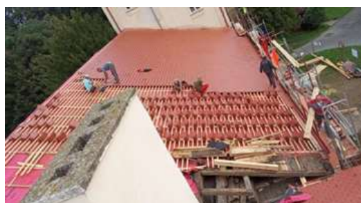
Rekonštrukcia striech v „KAŠTIELI“, ZSS Horné Obdokovce; 2023
