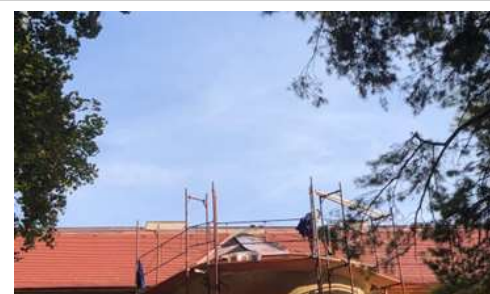
Rekonštrukcia striech v „KAŠTIELI“, ZSS Horné Obdokovce; 2023
