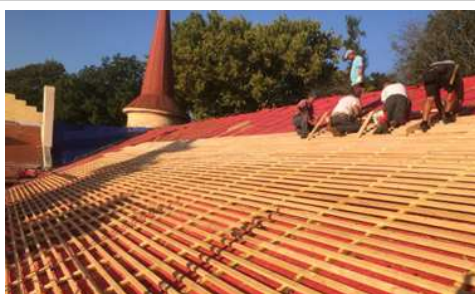
Rekonštrukcia striech v „KAŠTIELI“, ZSS Horné Obdokovce; 2023
