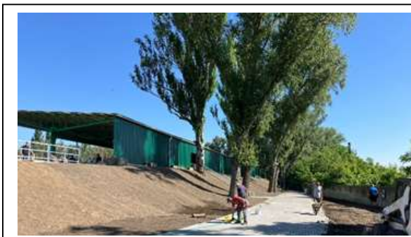
Mestský multifunkčný športový areál Nové Zámky - Sihot' – chodníky; 2022
