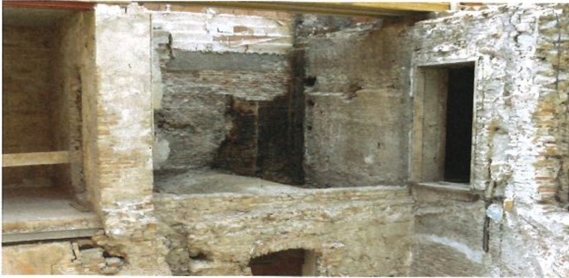
Rekonštrukcia polyfunkčného domu Bratislava
