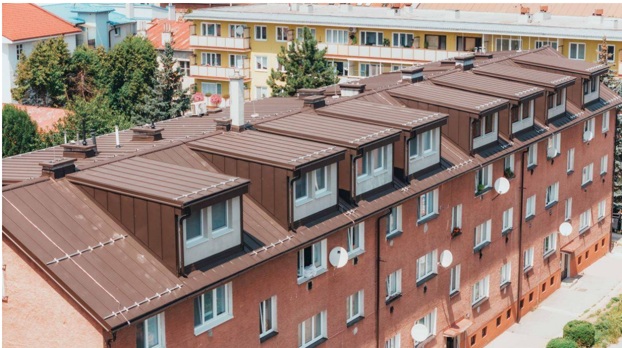
Realizácia: Projekt obnovy strešného plášťa bytového domu F. Mráza 284/3,5,7, Žilina
