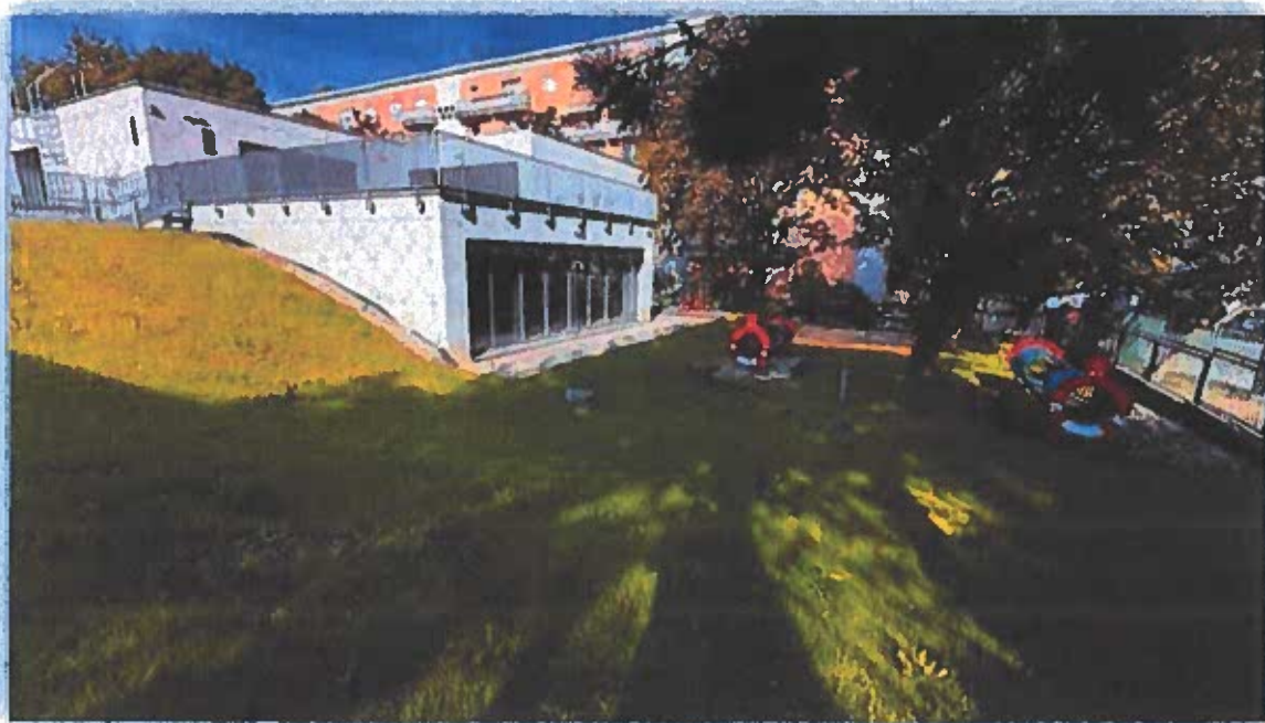
Obr. 1 Novostavba Materská škola Teplická, Bratislava
