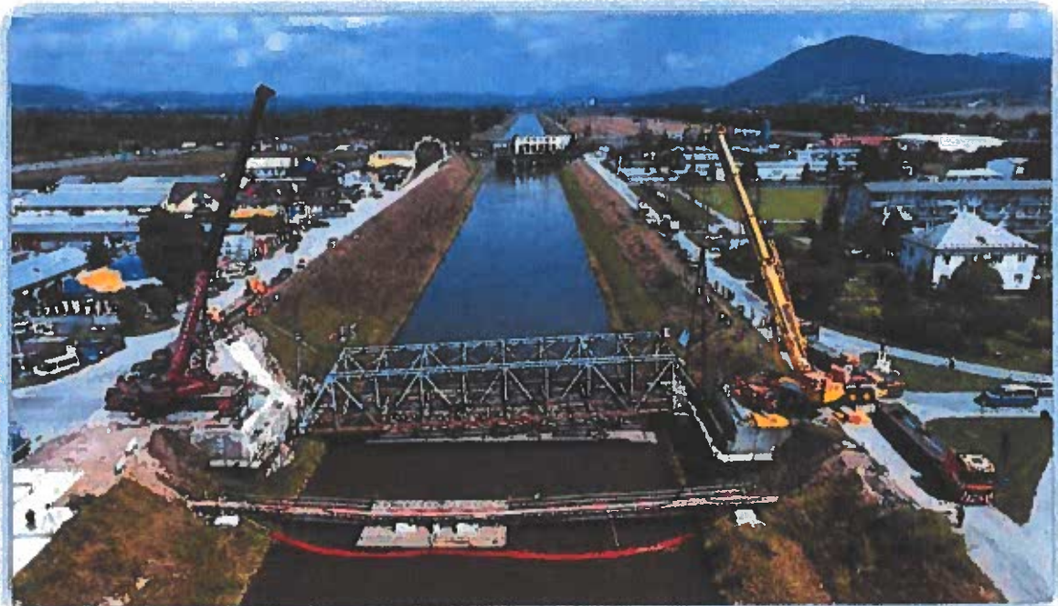
Obr. 6 Odstránenie a výstavba mostného objektu cez Vážsky kanál v Ilave na ceste II/574 - rekonštrukcia
