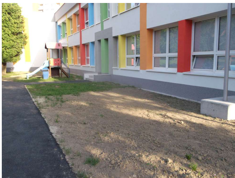
Zníženie energetických nákladov MŠ Komenského Bardejov
