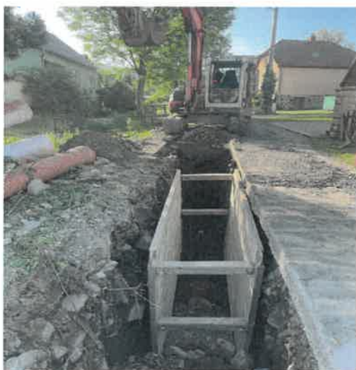
Kanalizácia Horná Štubňa
