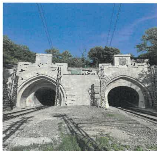
Rekonštrukcia Bratislavského tunela c. 2, ZST Bratislava hl. st.
