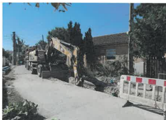
Bratislava, Hradská ul. – Sanácia vodovodu
