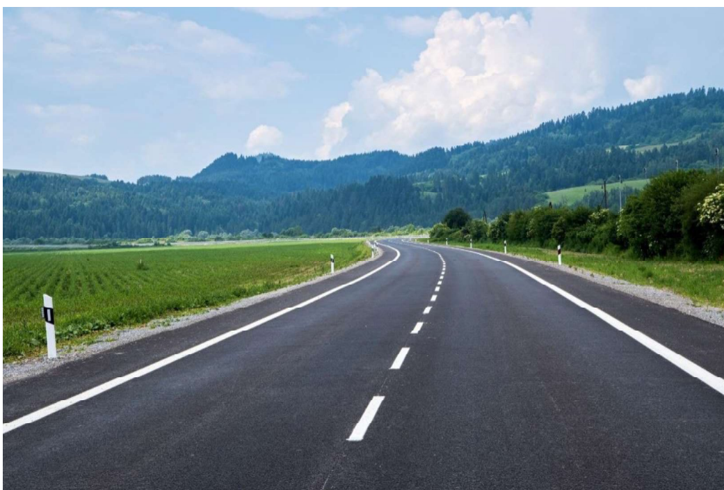
stavba: I/68 Plavnica, preložka cesty
