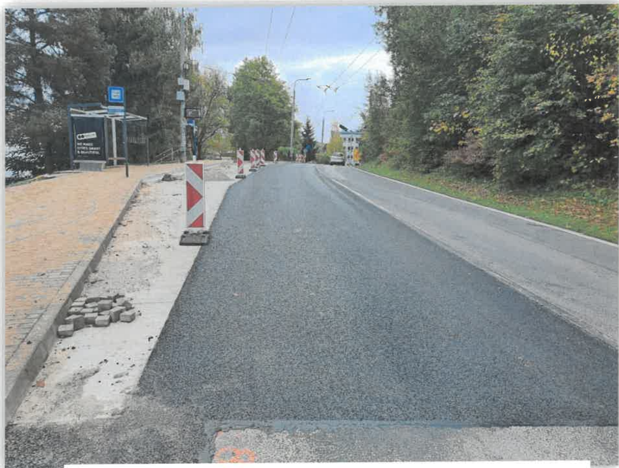
Rekonštrukcia zastávok MHD v meste Žilina – III.etapa
