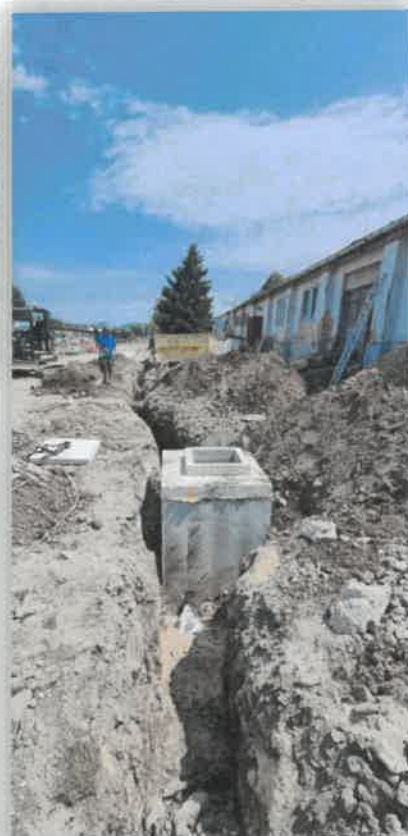
Envirocentrum areál SIM Martin - Priekopa
