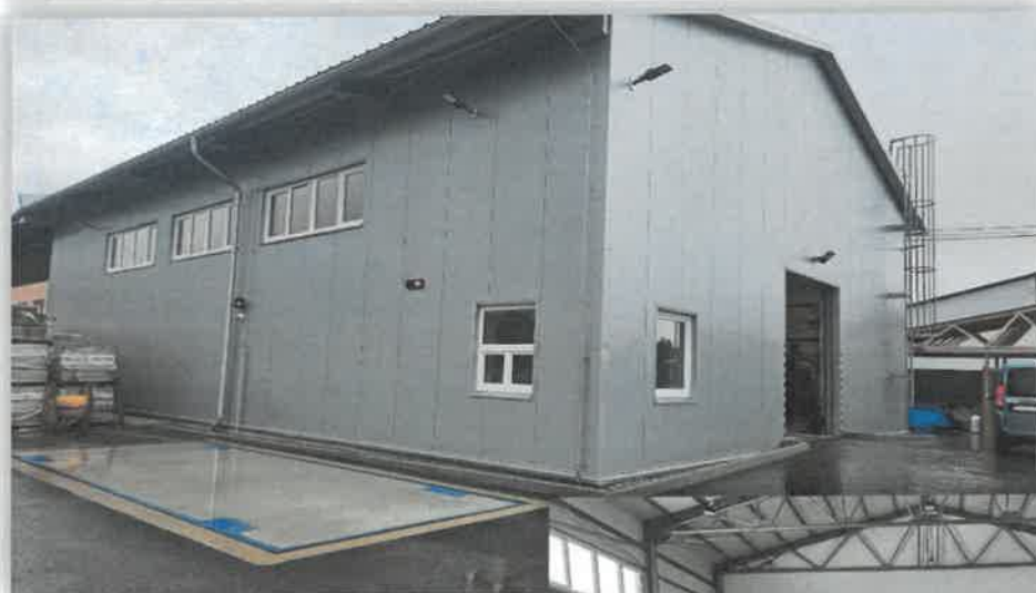
Envirocentrum areál SIM Martin - Priekopa
