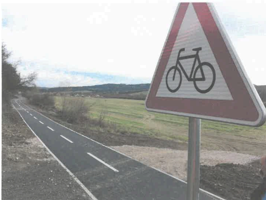
Cyklochodník EUROVELO 11 Stará Ľubovňa Začatie: 07/21, Ukončenie: 01/22, Náklady: 316 tis. € s DPH
