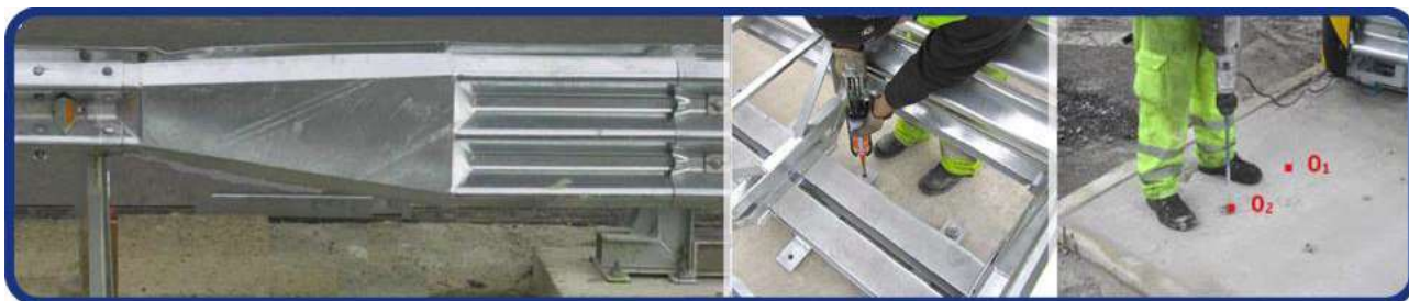
Montáž a osádzanie záchytného bezpečnostného zariadenia – tlmíče nárazu (zvodidlá).
