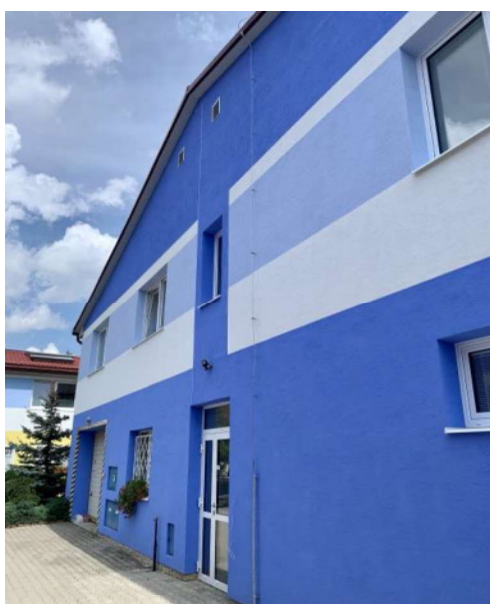
Hala po rekonštrukcii.
