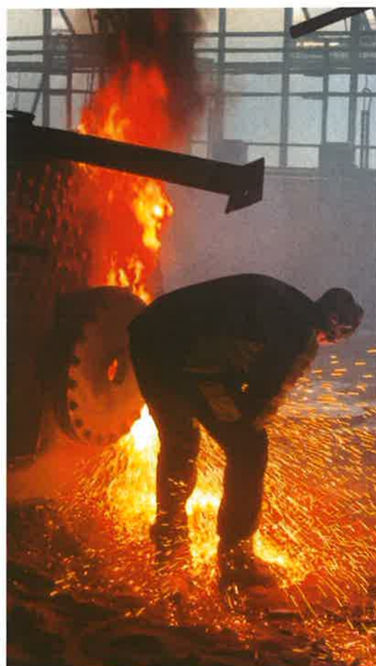
demolácia technologických zariadení MH Teplárensky holding, a. s.
