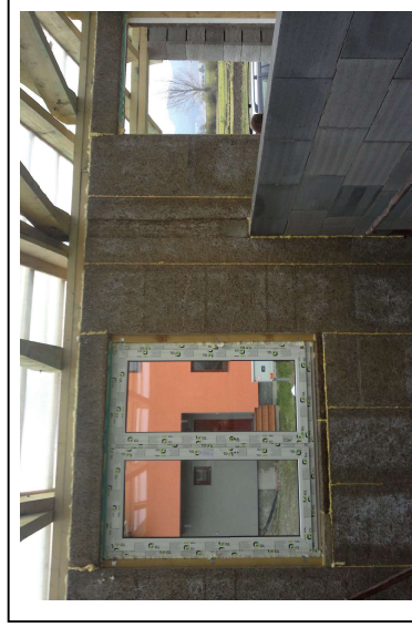
Novostavba - rodinný dom Ružomberok r. 2021
