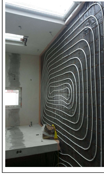
Novostavba - rodinný dom Ružomberok r. 2021
