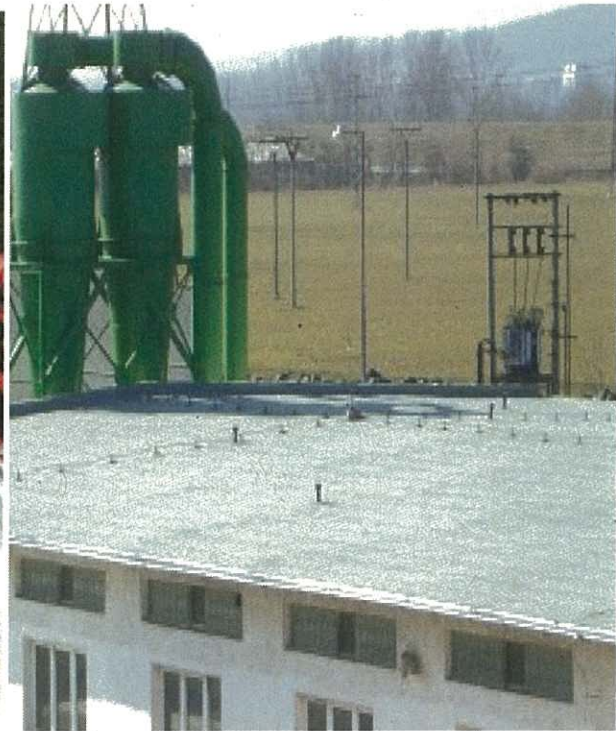
Oprava strechy Beluša
