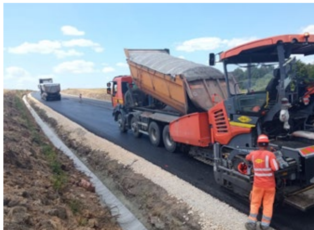
📍 Rekonštrukcia cesty č. II_581 Nové Mesto nad Váhom - Myjava
