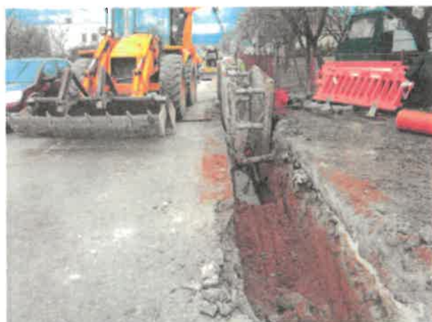
Obec Bystričany - Verejná kanalizácia a ČOV v obci Bystričany
