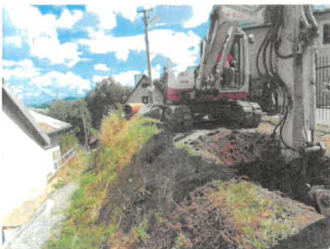
Mesto Banská Štiavnica - Rekonštrukcia miestnej komunikácie ulice Dolná Reša Banská Štiavnica
