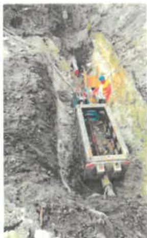
TURVOD a s - Turany oprava havárie vodovodu
