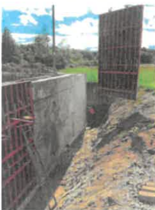
Obec Sechleby - Sechleby - Kanalizácia a ČOV
