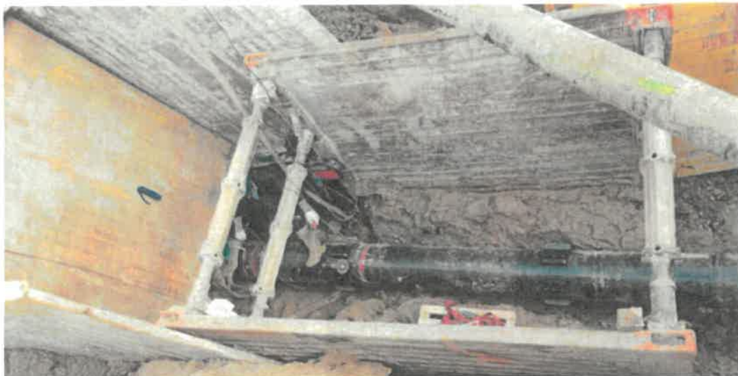
Brněnské vodárny a kanalizace a.s. Brno - Brno Odbojářská ulice oprava havárie
