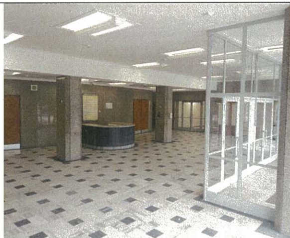
STU v Bratislave rekonštrukcia- učebne -spoločné priestory
