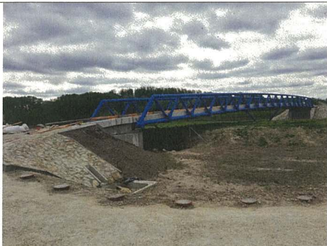
Výstavba mosta pre peších a cyklistov Dobrohošť-Dunakiliti
