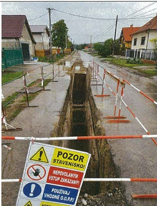
Kanalizácia Lúč na Ostrove
