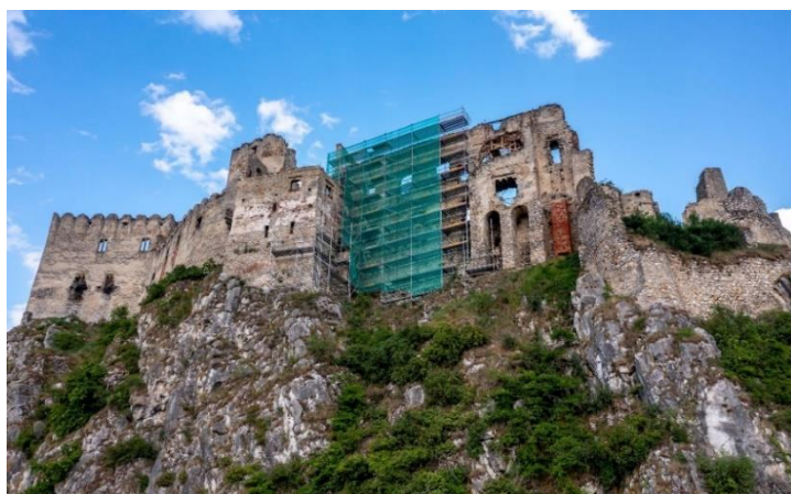
Hrad Beckov – Rekonštrukcia západného paláca
