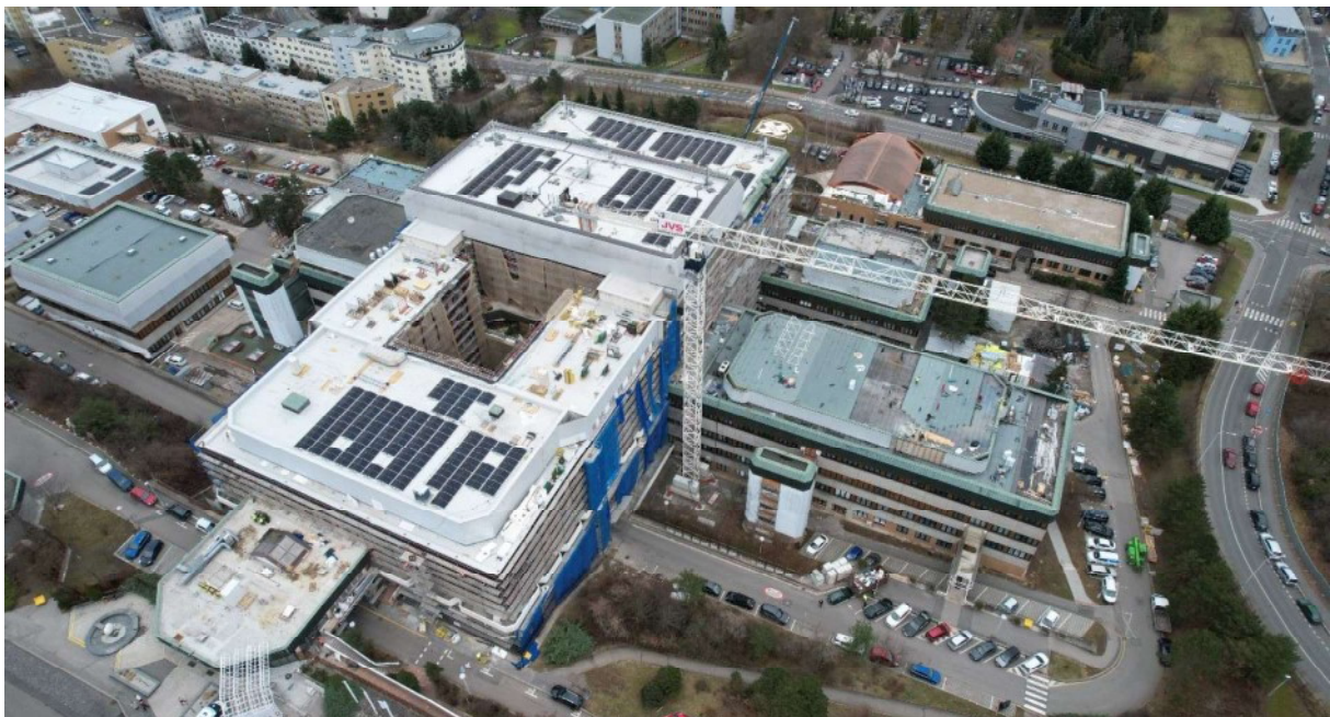
Zníženie energetickej náročnosti budov nemocnice na Homolke Praha – Zateplenie objektov
