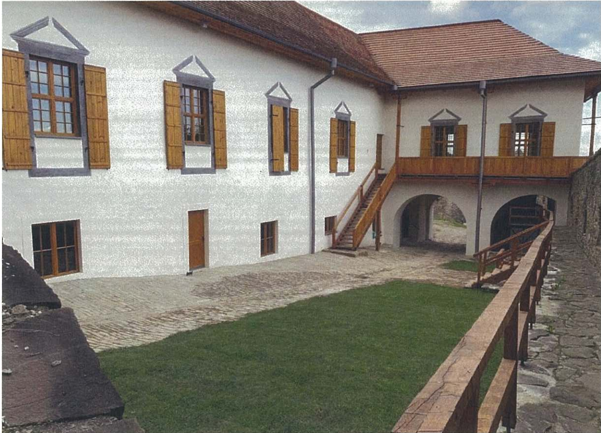
Foto č. 3 – Palác Ľubomirských – obnova objektu – rekonštrukcia – hrad Stará Ľubovňa
