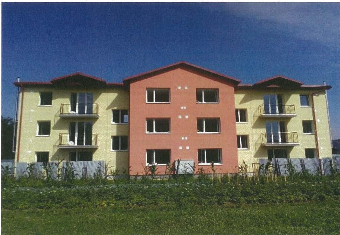
Foto č. 1 – Bytový dom Jastrabie nad Topľou – 12 b.j.
