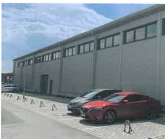
Stavba po rekonštrukcii
