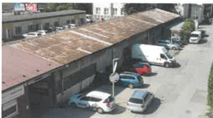
Stavba pred rekonštrukciou
