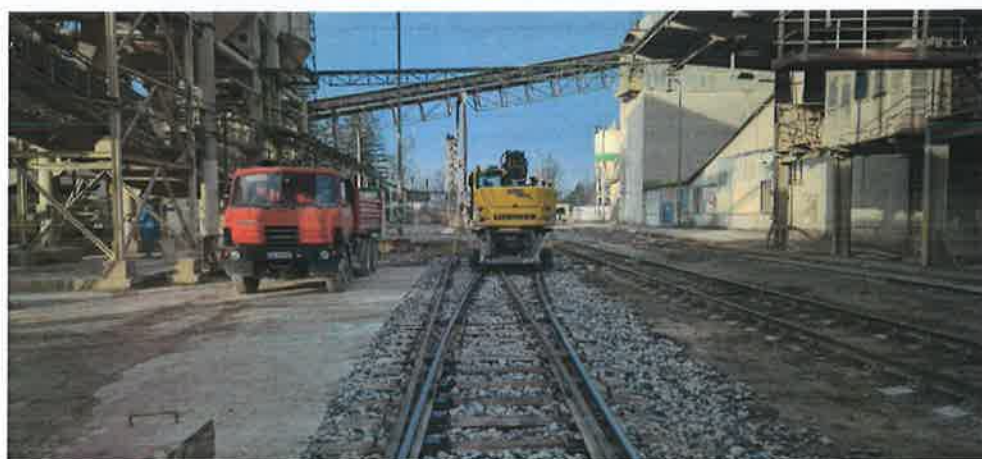
Oprava železničnej vlečky Dolvap s.r.o.
