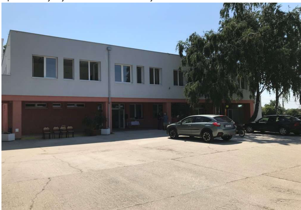
Oprava fasády objektu SLSP a.s. Banská Bystrica
