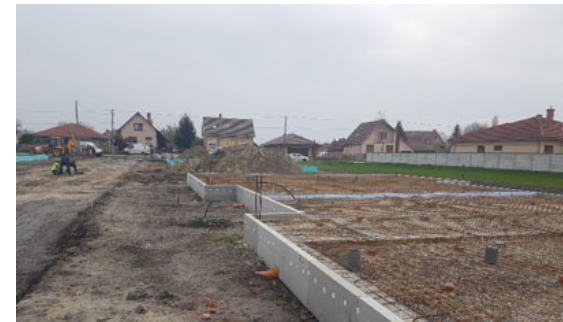
Výstavba 8 rodinných domov v obci Ohrady, r. 2023
