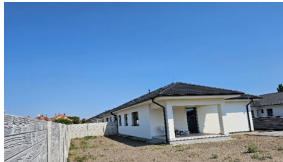
Výstavba 8 rodinných domov v obci Ohrady, r. 2023
