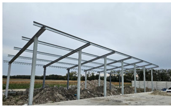
Výstavba zberného dvoru v obci Tomášikovo, r.2024
