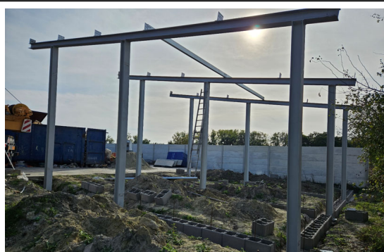
Výstavba zberného dvoru v obci Tomášikovo, r.2024
