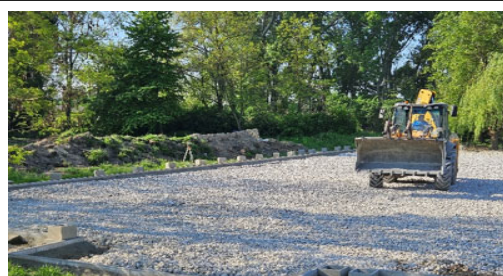
Výstavba multifunkčného ihriska v obci Kralovičové Kračany, 2025
