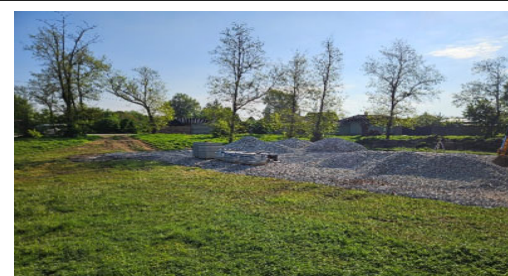
Výstavba multifunkčného ihriska v obci Kralovičové Kračany, 2025
