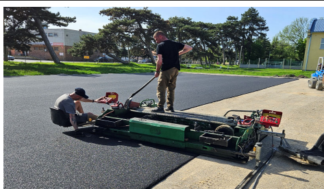
Výstavba multifunkčného ihriska v obci Tomášikovo, r.2025
