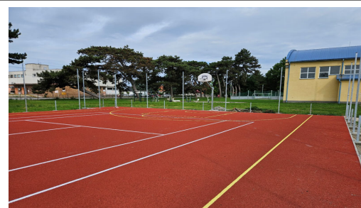
Výstavba multifunkčného ihriska v obci Tomášikovo, r.2025
