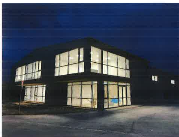
Názov stavby: Výstavba administratívno-skladovej haly 1, Atrium Invest s.r.o. v Komárne (rok 2022)
