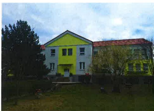
Názov stavby: Zníženie energetickej náročnosti budovy MŠ Mieru v Komárne (rok 2023)
