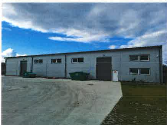
Názov stavby: Výstavba skladovej haly 2, Atrium Invest s.r.o. v Komárne (rok 2022)
