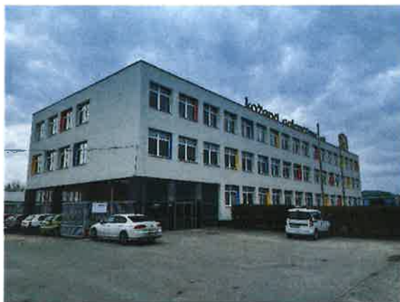
Názov stavby: Zníženie energetickej náročnosti budovy Koženej galantérie v Komárne (rok 2021)
