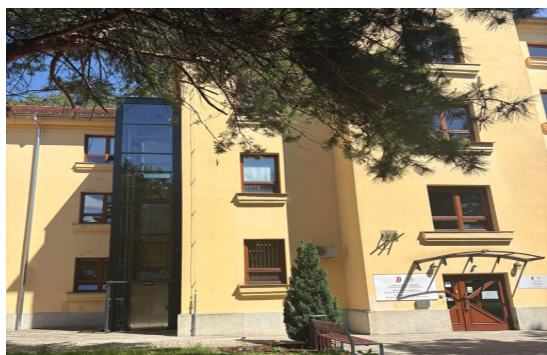
Obnova budovy FEI UJS - Komárno, r.2024
