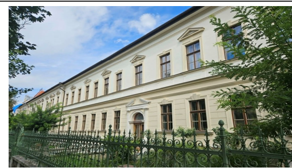
Obnova budovy ZŠ na Ul. Pohraničnej - Komárno, r.2025
