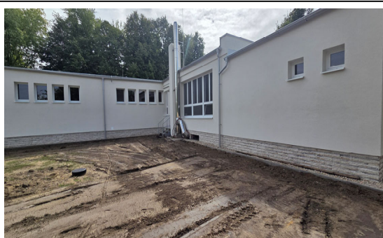
Zvýšenie energetickej účinnosti materskej školy - Nesvady, r.2025
