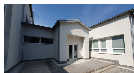
Zníženie energ. náročnosti budovy ZŠ a prestavba časti budovy na škôlku v Dulovciach. r.2023
