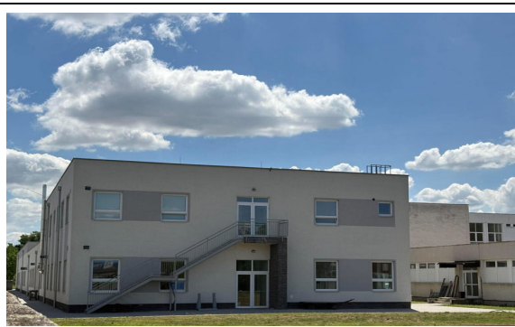
Novostavba školských dielní pri SOŠ technickej v Komárne, r.2024
