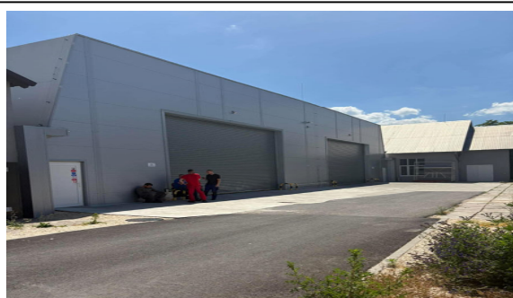
Prístavba montážnej haly p. č. 1714/3, Elektráreňská 3726/10, Komárno, r.2025
