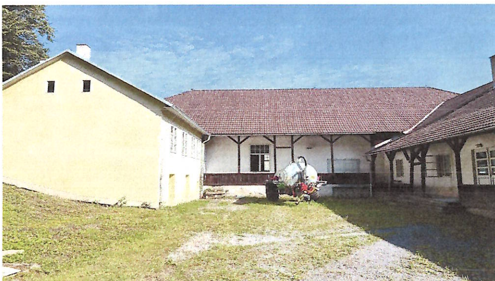
Obec Svätý Anton – Obnova budovy kultúrneho domu v obci Svätý Anton (pred realizáciou)
