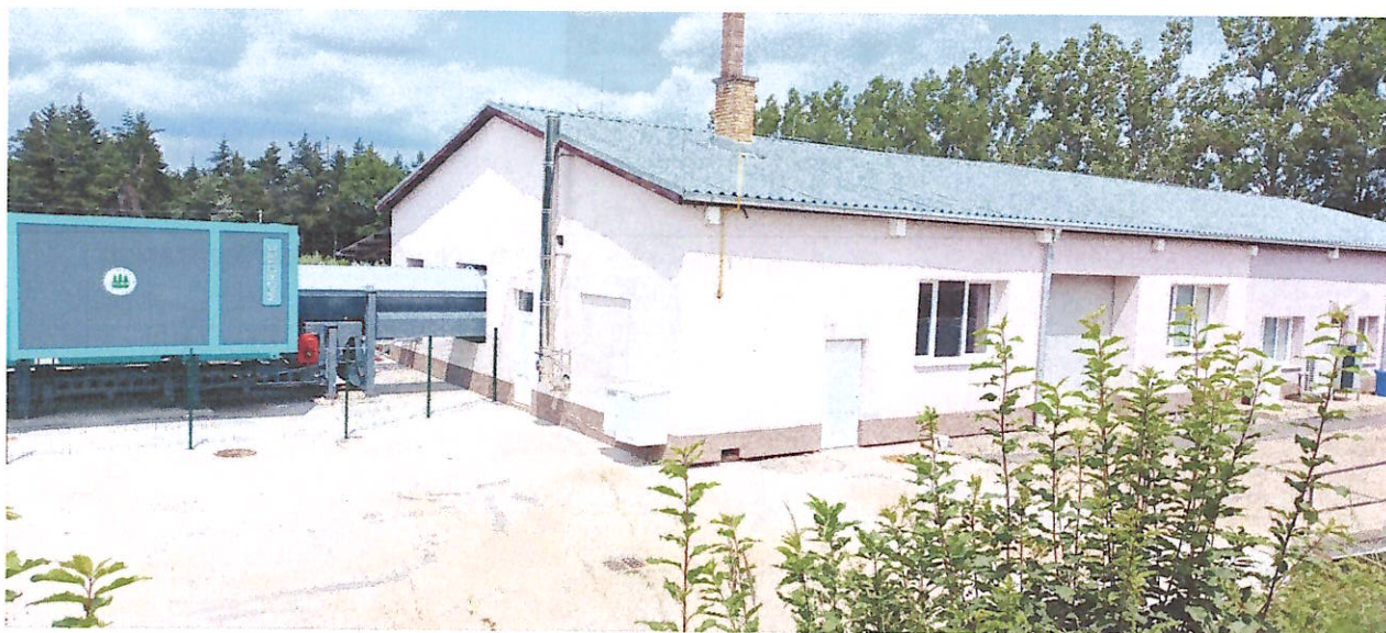
Národné lesnícke centrum – po vykonaní stavebných úprav
