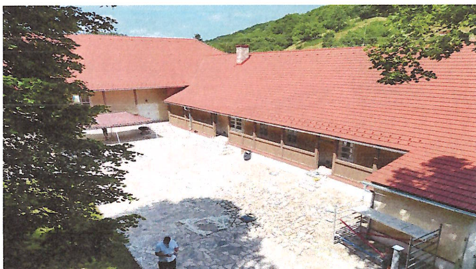
Obec Svätý Anton – Obnova budovy kultúrneho domu v obci Svätý Anton (po realizácii)
