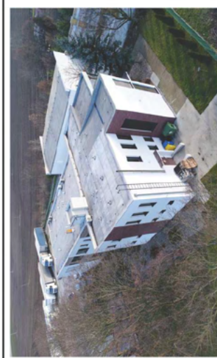
Novostavba, prístavba SPEED LINE s.r.o., Štúrovo r. 2018
