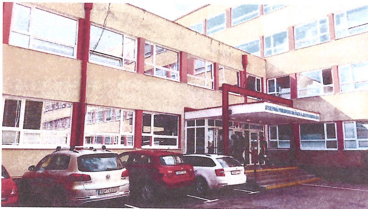
SPŠ J. Murgaša B. Bystrica – pred rekonštrukciou
