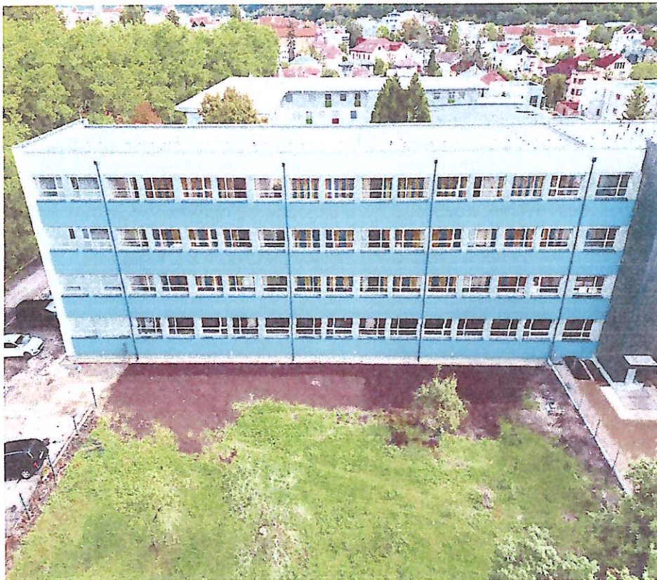
SPŠ J. Murgaša B. Bystrica – po rekonštrukcii
