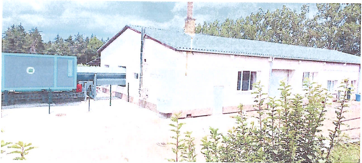
Národné lesnícke centrum – po vykonaní stavebných úprav
