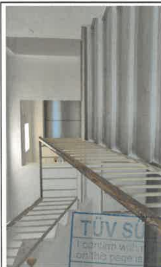
Rekonštrukcia bytovky DD a DSS, Veľký Krtíš, 2023
