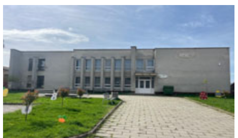
Zníženie energetickej náročnosti Kultúrny dom, Plášťovce, 2025
