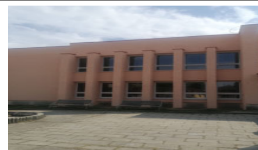
Zníženie energetickej náročnosti Kultúrny dom, Plášťovce, 2025
