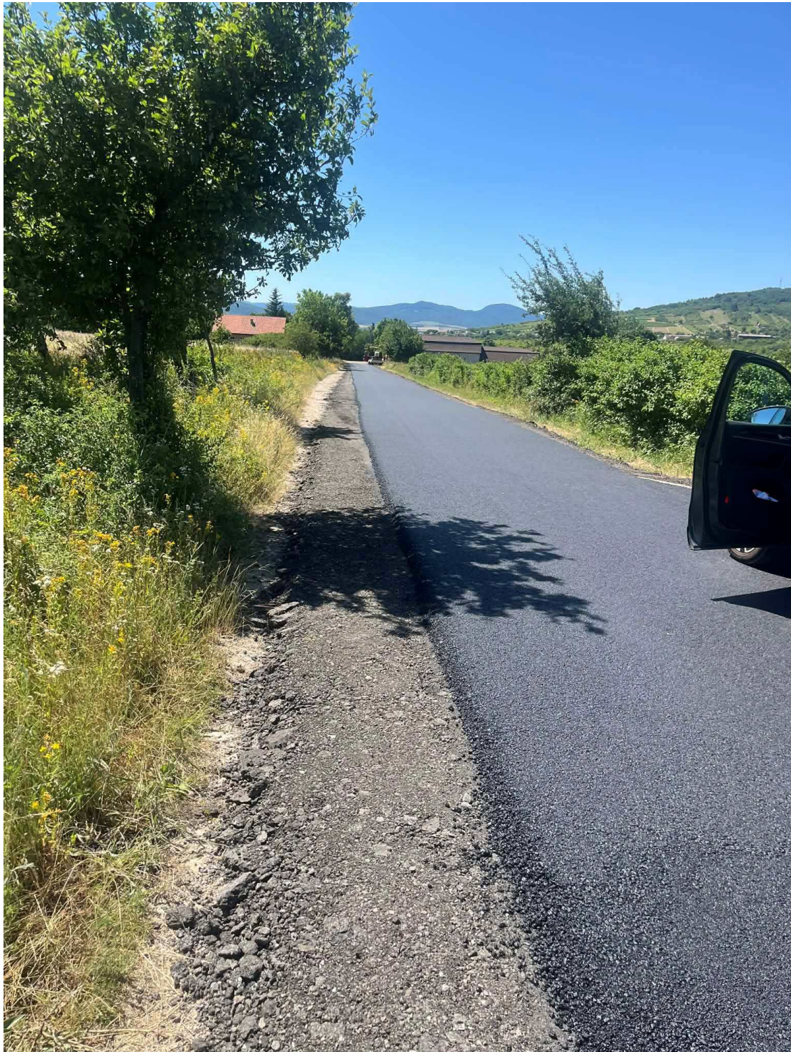
Modernizácia miestnych komunikácií obce Bara_2
