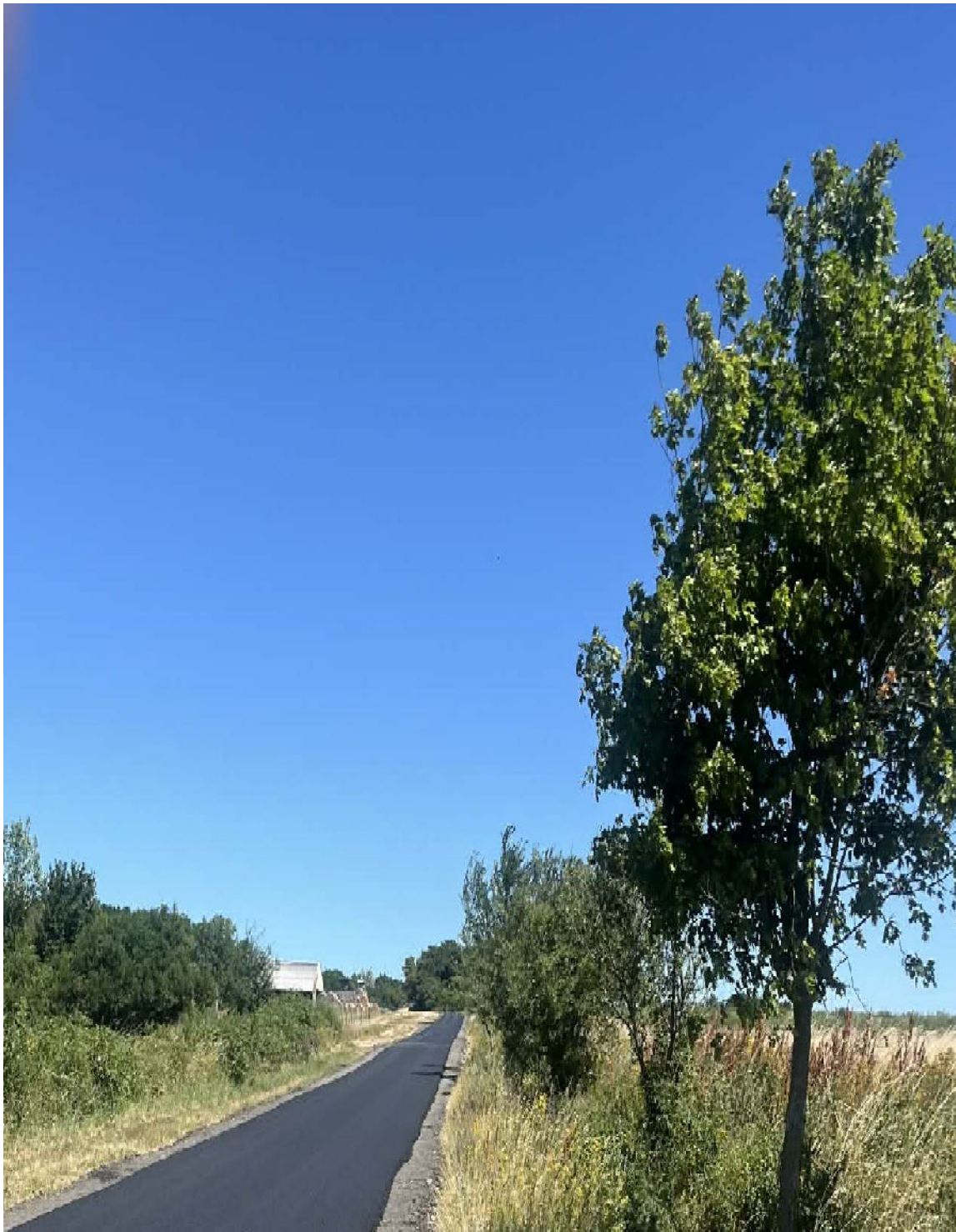
Modernizácia miestnych komunikácií obce Bara_1
