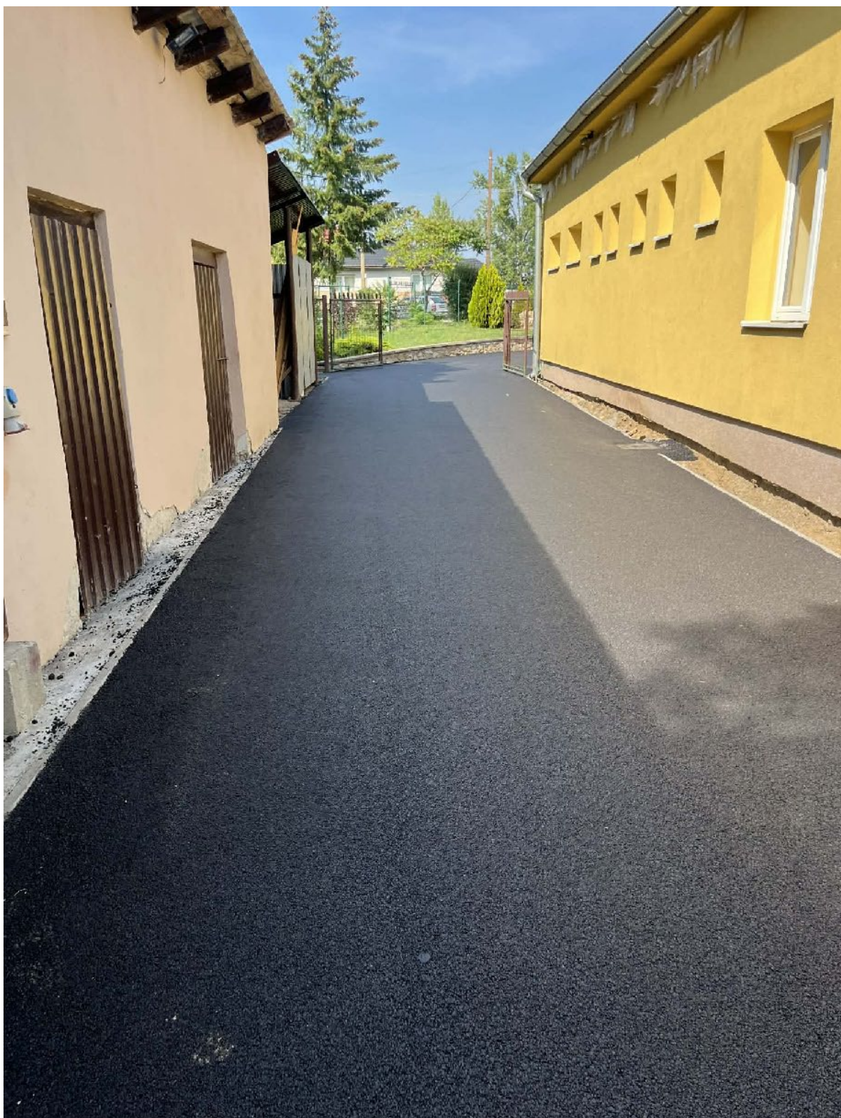
Rekonštrukcia chodníkov v obci Zbeňňov_2
