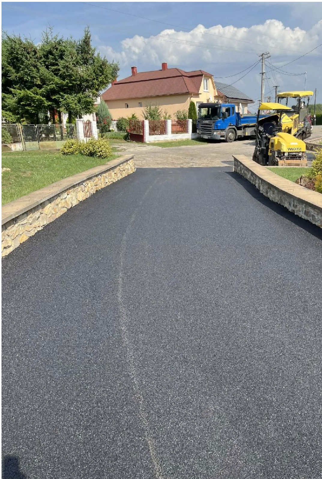
Rekonštrukcia chodníkov v obci Zbeňňov_1
