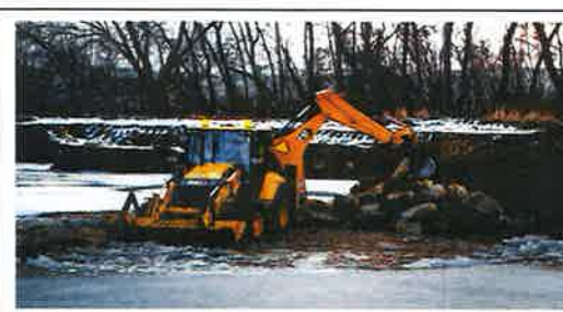
Zemné práce Rezidencia Jána Pavla II Prešov, 2025
