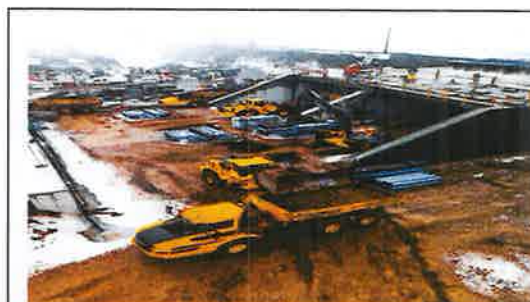
Železničný most Poprad, 2024
