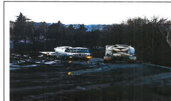
Betonáž Bytový komplex Rusínska, 2025-2026
