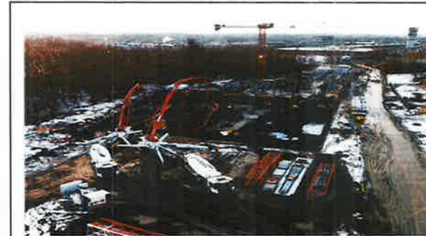
Rusínska Prešov- Veľkoplošné betonáže 1-2026
