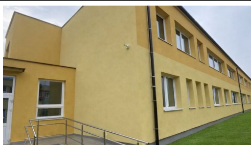
Športová hala, Preseľany, r.2024
