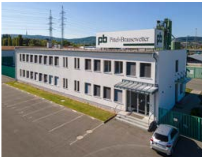
Administratívna budova – Stará Vajnorská 1
