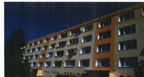
Poltár Sklárska ul. - Zateplenie opláštenia panelového domu, 2021
