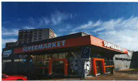
COOP Jednota Detva - Rekonštrukcia fasády, 2021
