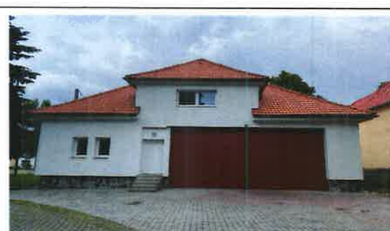
Hasičská zbrojnica Detva - Rekonštrukcia a modernizácia, 2020
