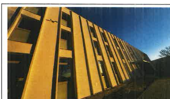
Spojená škola Detva – Modernizácia dielni zateplenie a vnút. rekonštrukcia, 2023
