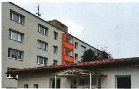
DD A DSS LUNA Brezno - Zateplenie objektu, 2024
