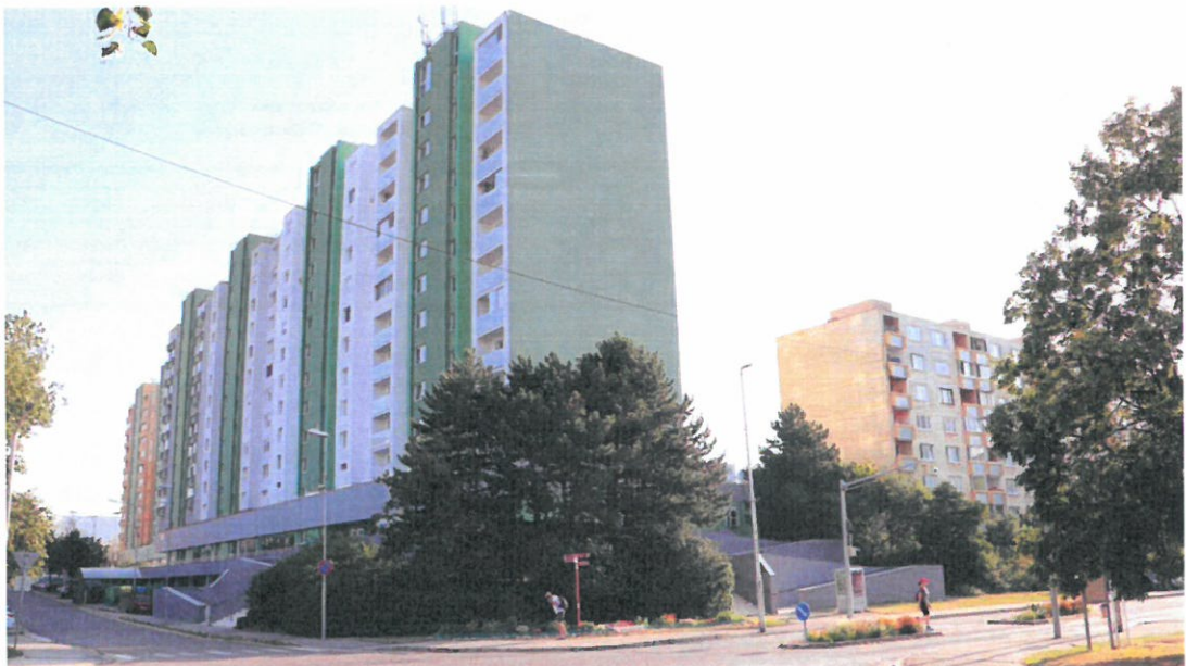
Obrázok 1 - Obnova panelového bytového domu
