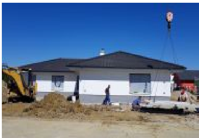
Stavba Čierna voda – bungalov
