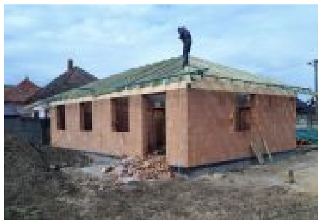
Výstavba RD Diakovce – bungalov
