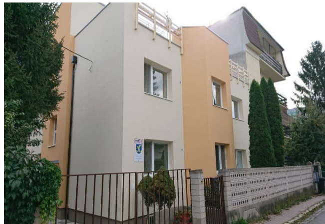
Rekonštrukčné práce Domov sociálnych služieb Bratislava
