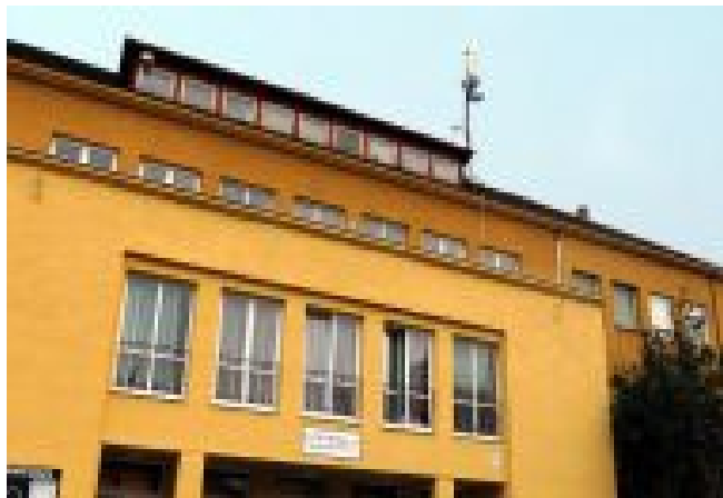
Rekonštrukcia strechy KD Cultus Bratislava
