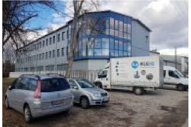
Rekonštrukčné práce Milking
