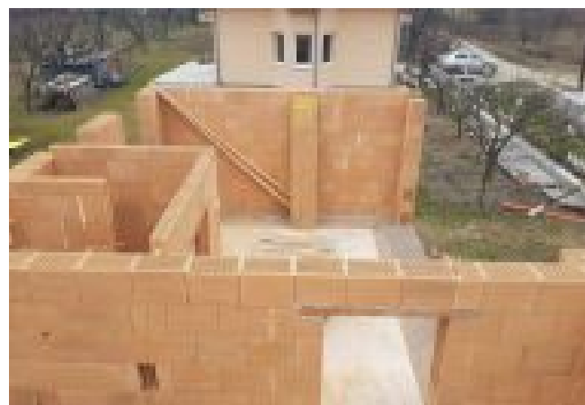
Výstavba RD Vinosady - bungalov
