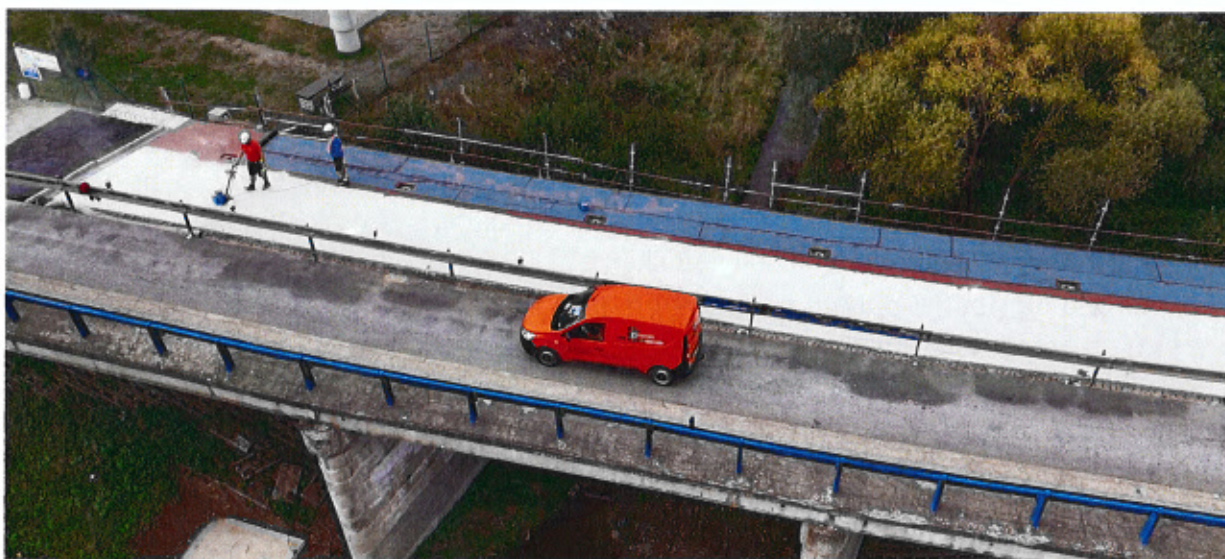
Rekonštrukcia ciest III/3541 a III/3586, Ladomírová
