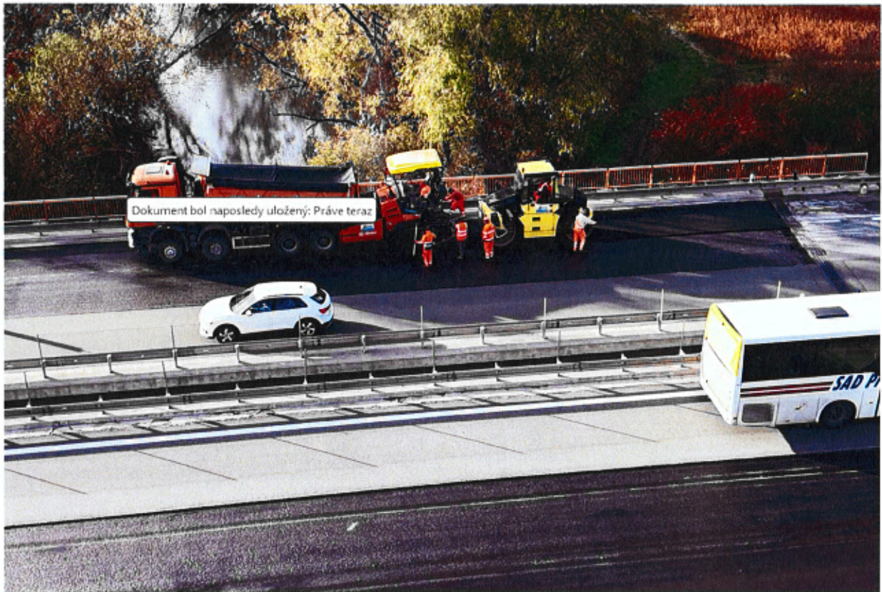
Pokládka asfaltu na D1 Prešov-Košice
