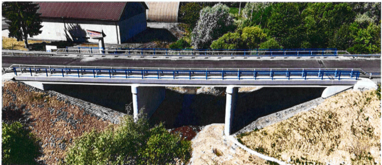
Rekonštrukcia mosta 3586-004 Šemetkovce
