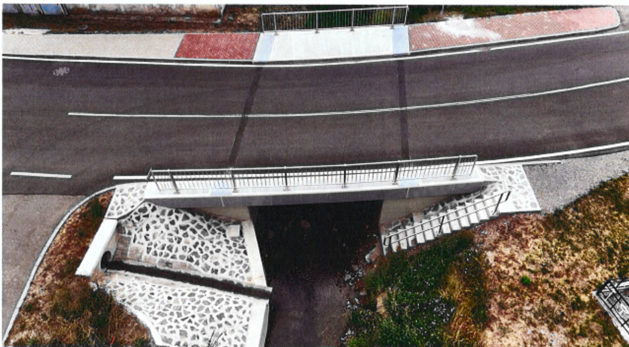
Rekonštrukcia mosta M7723 (III□3076-006) cez Strážsky potok v meste Poprad-Stráže
