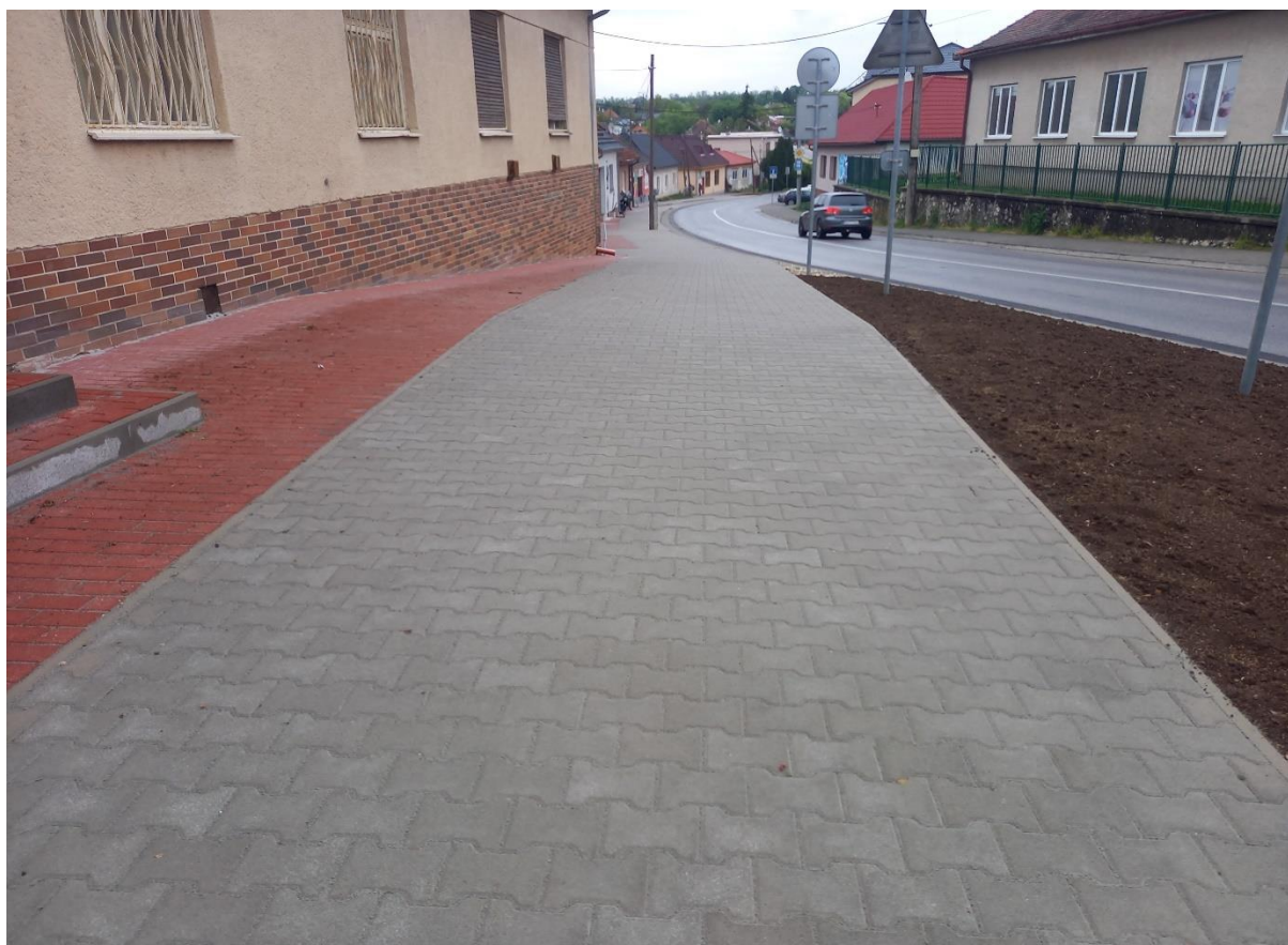
Rekonštrukcia chodníka v obci Mojímírovce.
