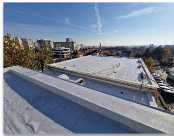
Oprava strechy, Bratislava – Rača
