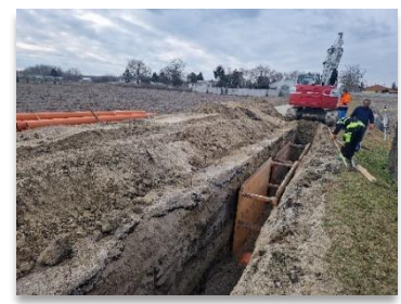
Realizácia kanalizácie, Horný Bar
