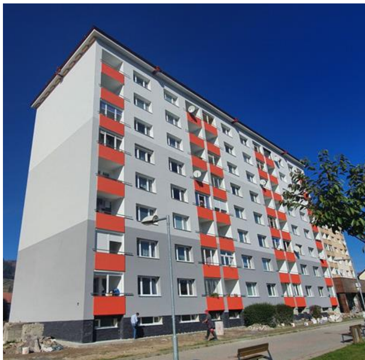
Realizácia: Obnova bytového domu ČSA 1301, Kysucké Nové Mesto
