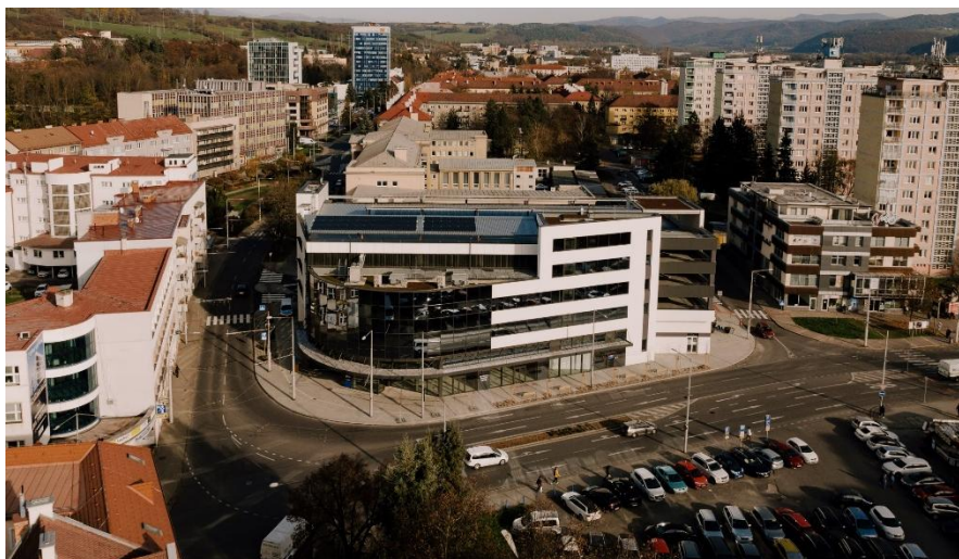
Parkovací dom CENTRUM, Banská Bystrica
