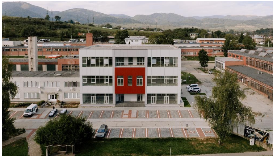
Rekonštrukcia časti prevádzkovej budovy (SAD BB), Banská Bystrica
